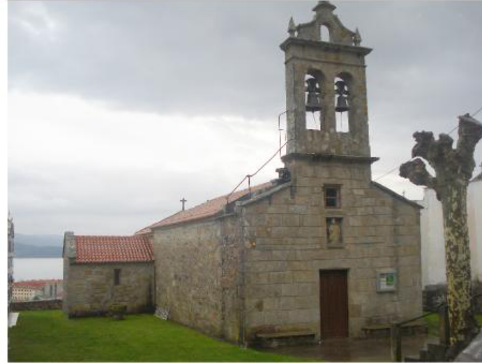
A igrexa actual de S. Martiño de Duio é unha construción iniciada no 1.717, como di a inscrición na xamba esquerda da ábside: "Ecclesia esta esta fundamentis instaurata archipo Ludovico, rectore Matheo Valdivieso, año de 1717".
